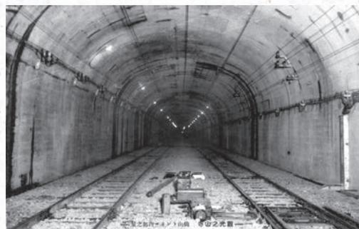
図5 = 仙山トンネル内に設けられた面白山信号場の断面拡幅区間
