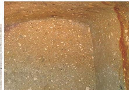
図7 = 仙台に広く分布する広瀬川凝灰岩には、白い軽石のパッチが含まれていて美しい。掘りやすく、水を通しにくく、比較的堅牢なので、防空壕に適していた
