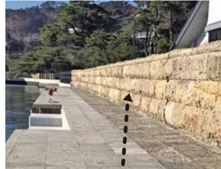
松島海岸の堤防
