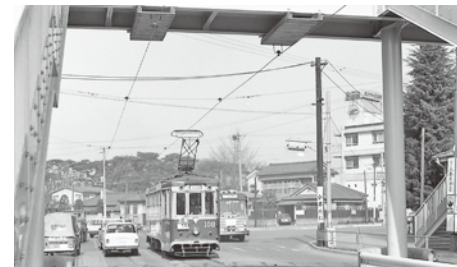
架線を吊るす碇子や接触防止ガード、階段を支える支柱が見える。写真/平田 誠
