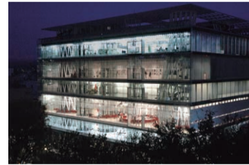
せんだいメディアテーク南側のガラス壁面はダブル・スキンという二重構造。屋上の開口部の開け閉めで放熱・蓄熱両方の効果を発揮
