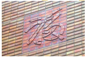
▲2号館の5階付近の外壁をチェック!
