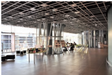
せんだいメディアテーク7階 復旧状況
